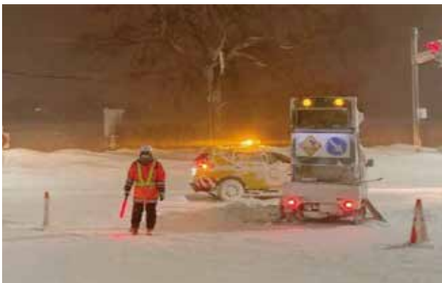
通行規制の状況 (国道337号江別市～石狩市、23年1月)
